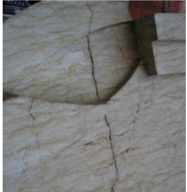
Crevice in Nembro rosato marbre
